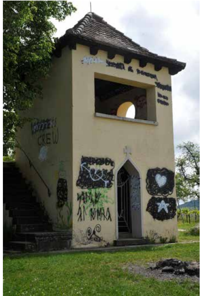
Verschmiert und beschädigt wird das Jägerhäusle seit Jahren immer wieder. Das Bild zeigt das Ergebnis des Vandalismus vor zehn Jahren.
